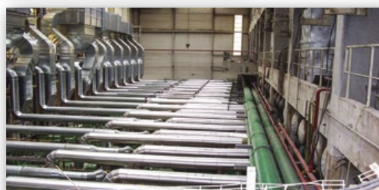
Fourniture et pose de 32 lignes d'échappements moteurs
