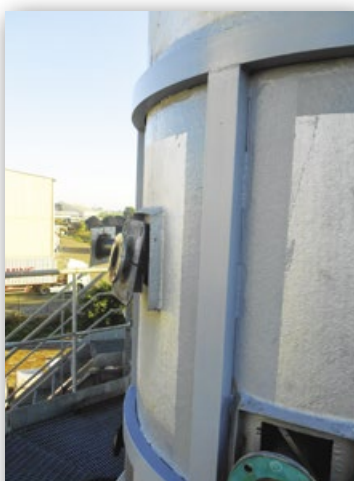
Pose de corset renfort structurel pour création d'ouvertures
