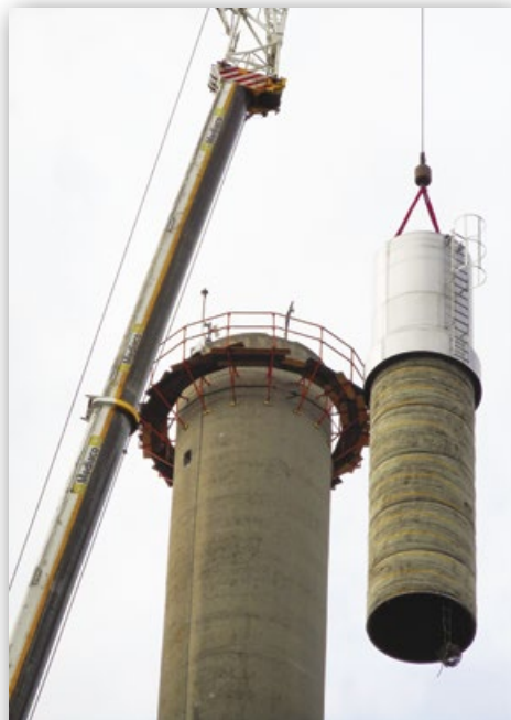
Tubage d'une cheminée (80m)
