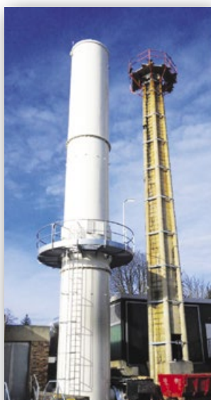
Démolition de cheminée béton Monnoyer (40m) et remplacement par une cheminée neuve métallique
