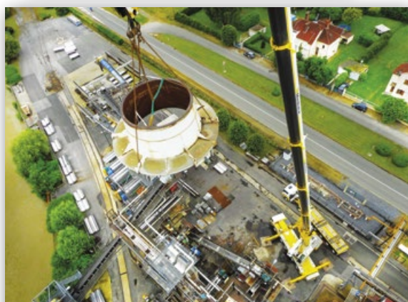
Etude, fabrication et pose de convergent pour mise en conformité des vitesses d'éjection des fumées
