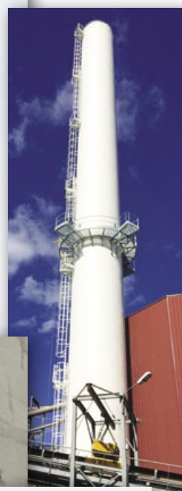
Réparation fût porteur béton 60m et mise en peinture
