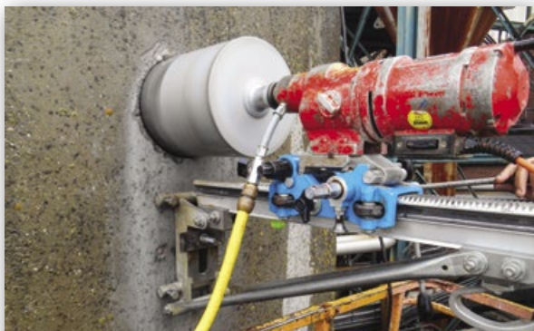
Carottage pour prélèvements ou passage technique
