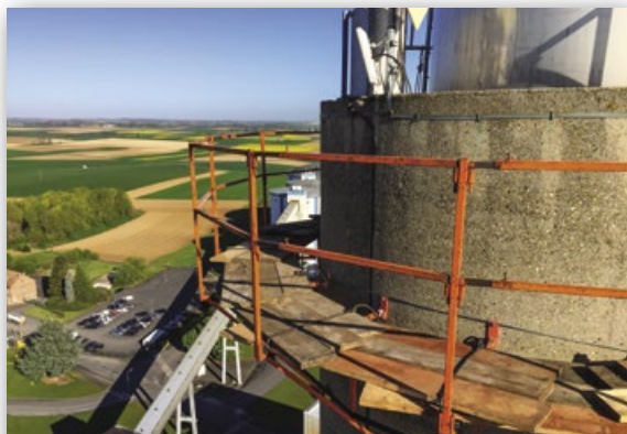
Echafaudage en Consoles en cours de montage sur cheminée de 80m
