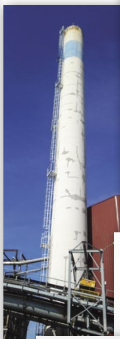
Réparation fût porteur béton 60m et mise en peinture
