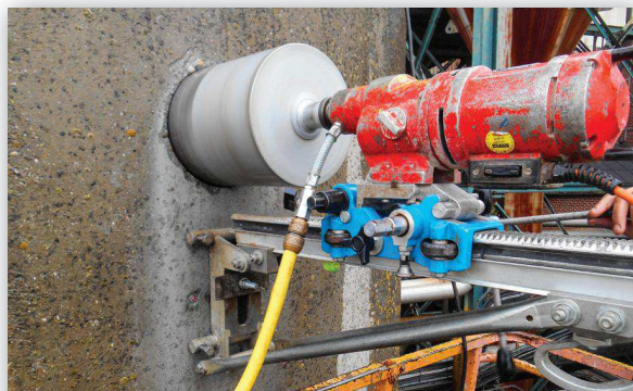
Carottage pour prélèvements ou passage technique
