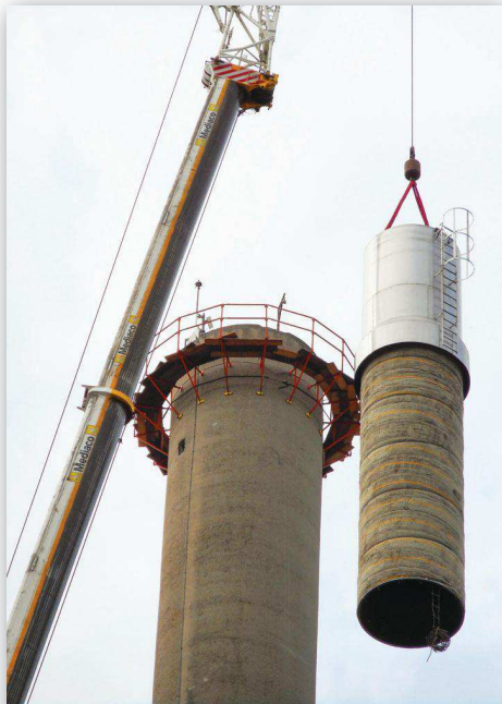
Tubage d'une cheminée (80m)
