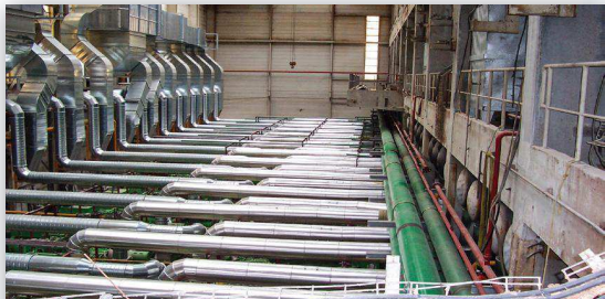
Fourniture et pose de 32 lignes d'échappements moteurs
