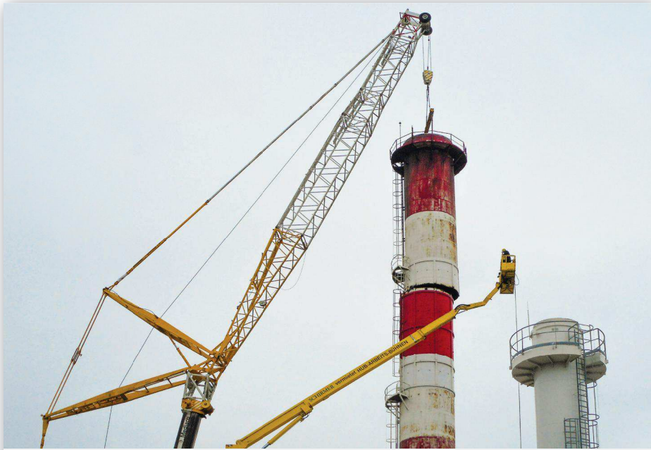
Démantèlement de cheminée (73m). Grue 750 tonnes – Nacelle 87m
