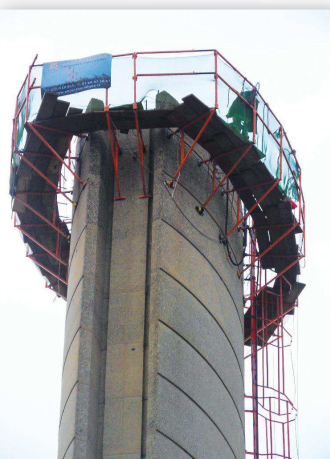
Echafaudage sans emprise au sol
