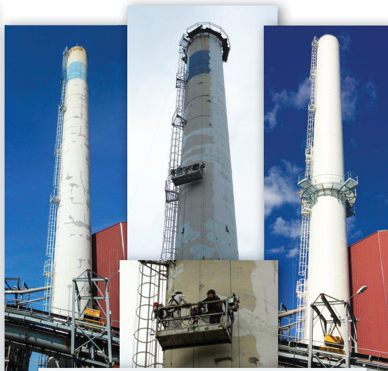
Réparation fût porteur béton 60m et mise en peinture
