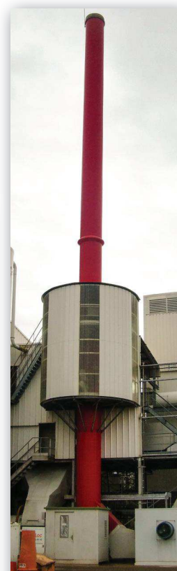
Réalisation d'abris sur passerelles de mesures réglementaires
